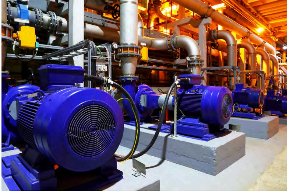
Figure 2-12. Les moteurs à haute efficacité, tels que les moteurs à induction certifiés IE2 (haute efficacité) et IE3 (efficacité supérieure), aident à réduire la consommation d'électricité de l'industrie dans le monde entier. IE2 et IE3 sont des certifications délivrées par la Commission internationale de l'électricité concernant le rendement des moteurs électriques.
