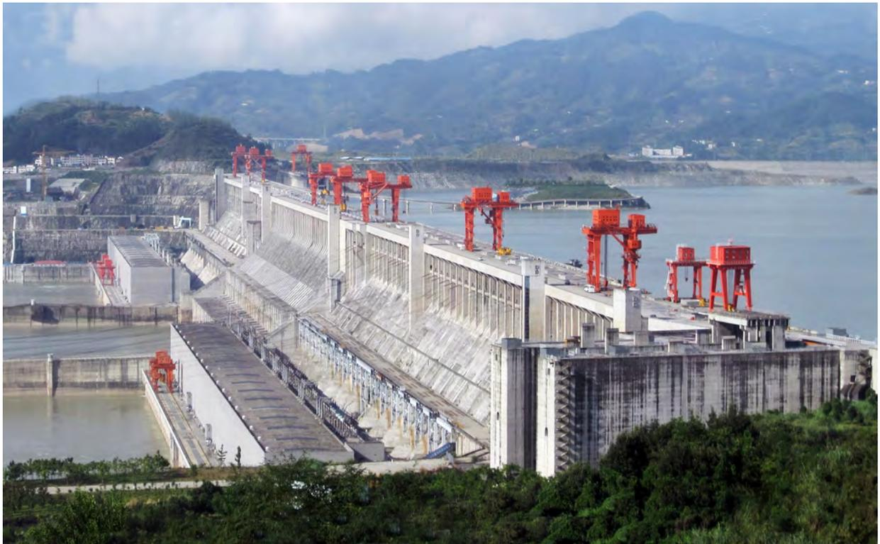
Figure 1-6. La majeure partie de l'électricité mondiale est produite par des alternateurs synchrones triphasés. La photo ci-dessus montre la centrale hydroélectrique du barrage des Trois-Gorges, sur le fleuve Yangtze, en Chine. Il contient trente alternateurs synchrones triphasés de 700 MW, pesant chacun environ 6 000 000 kg (environ 6000 tonnes).<sup>2</sup>
