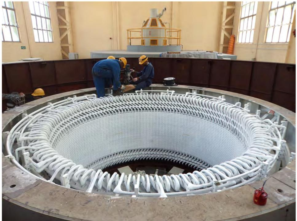
Figure 4-3. Stator d'un alternateur triphasé dans une centrale hydroélectrique.<sup>4</sup>
