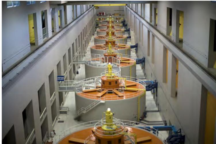
Figure 4-4. Salle d'alternateurs synchrones triphasés dans une centrale hydroélectrique.
